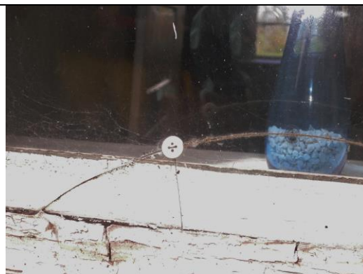
När inte ekonomin tillåter en ny fönsterruta så kan man laga den spräckta med två knappar.
